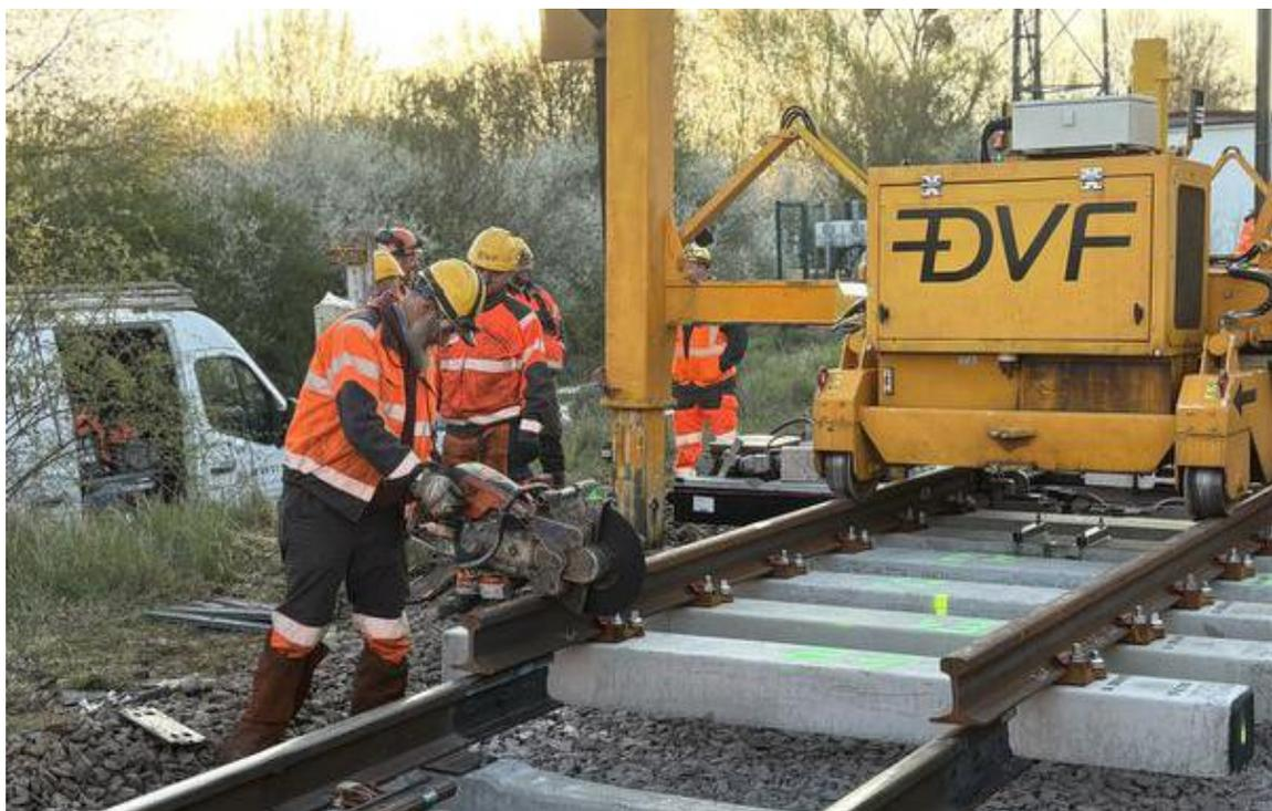
Équipé de sa tronçonneuse à rail, l'ouvrier va couper le morceau en trop pour l'ajuster à la partie du rail déjà existante. Adriane Carroger
